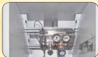
Удобные инсталляционные направляющие для установки газораспределительной фурнитуры*
