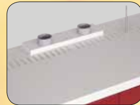
Специальная перфорация на крыше для вывода трубок газовых коммуникаций
