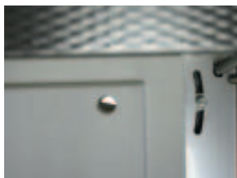
Отверстие для притока воздуха в двери
